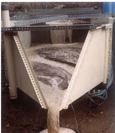
Fig 15.- Aforador tipo H en pleno funcionamiento (foto Lázaro).
